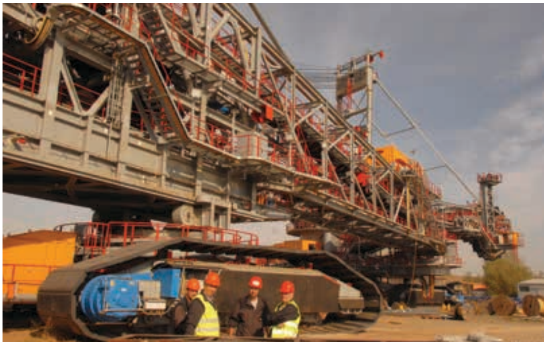
■ Завршена монтажа багера
